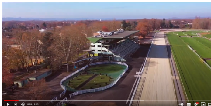
Grands travaux d'infrastructures sur l'Hippodrome de Pau (2019)
